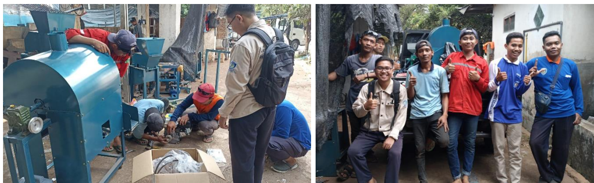
Gambar 3. Perakitan dan pengangkutan mesin (Sumber: Hasil Dokumentasi, 2022)
