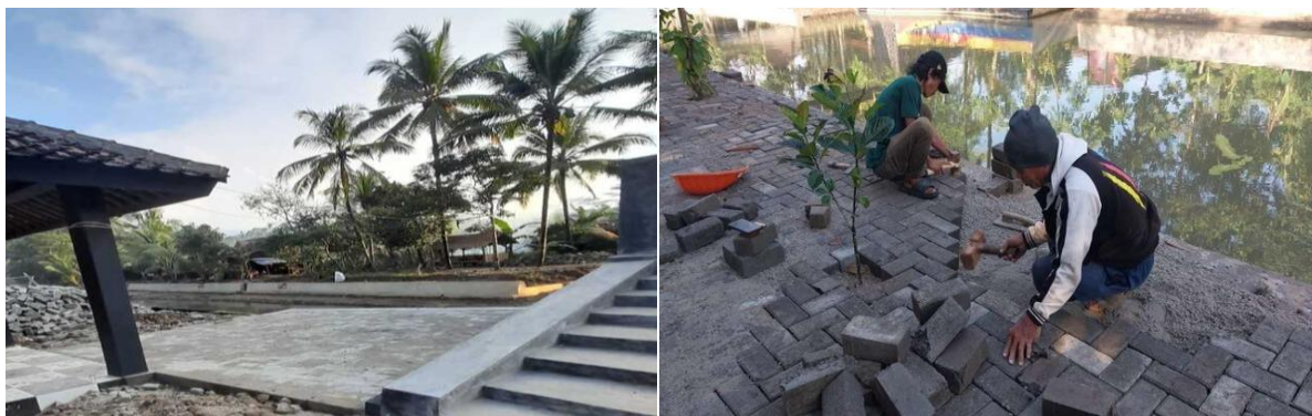
Gambar 4. Penggunaan paving block pada jalur wisata (Sumber: Dokumentasi tim, 2025)
